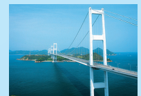
来島海峡大橋
