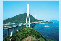
多々羅大橋
