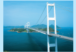
来島海峡大橋
