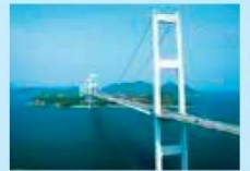
来島海峡大橋
